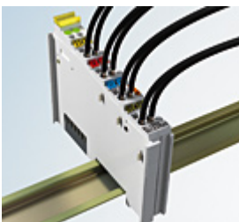
Fig. 16: Standard wiring
